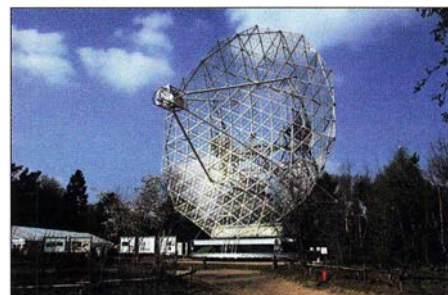
Der Durchmesser des Dwingeloo-Radioteleskops im Nordosten der Niederlande beträgt 25 m. Foto: CAMRAS
