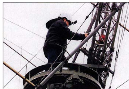
Der Drehkranz der 8er-Gruppe stammt aus einem ausgemusterten Marder-Panzer.
